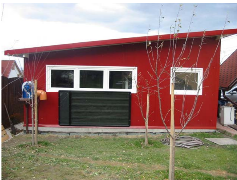
Montare pe orizontala panou solar 1500G in Sacele – Brasov
